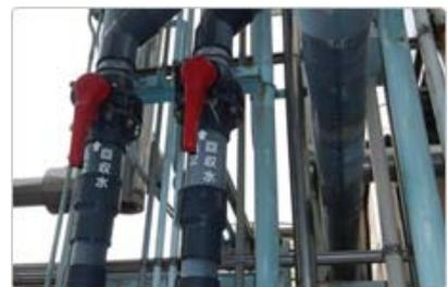
相模原製作所の回収・再生された水を洗浄工程に戻している配管
