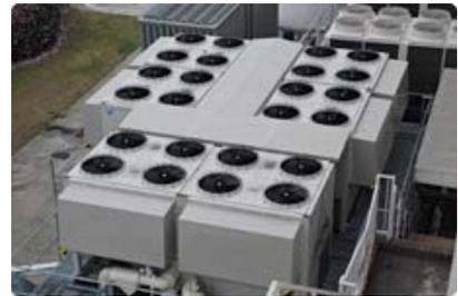
栃木ニコンプレジジョンの蒸気レス空調システムのヒートポンプチラー設備
