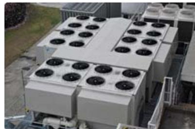
栃木ニコプレジジョンの蒸気レス空調システムのヒートポンプチラー設備
