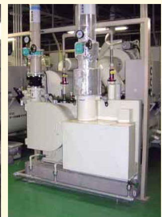
運転効率を向上させ、消費電力を削減する高効率型ターボ冷凍機
