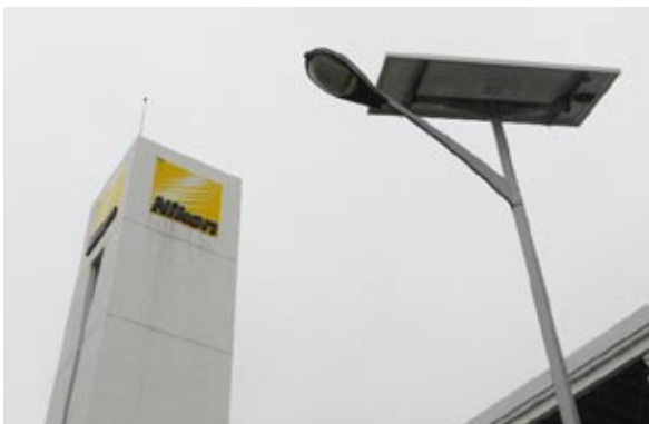
NTCの太陽光発電によるLED外灯
