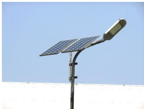
Nikon Imaging (China) Co., Ltd.の太陽光パネル付きLED外灯
