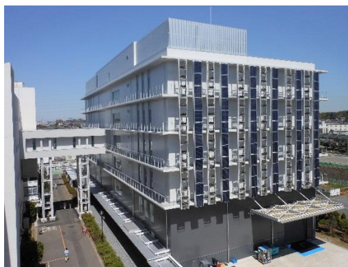
横浜製作所502号館
