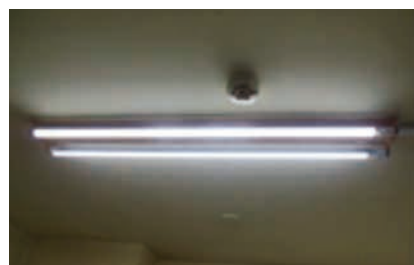
Nikon Imaging (China) Co., Ltd.の共用エリアの蛍光灯型LED照明
