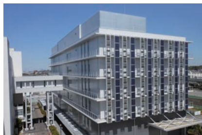
壁面に太陽光発電設備を装備した横浜製作所の建物
