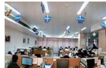
ほぼ全面にLED 照明を採用した Nikon India Private Limited のオフィス
