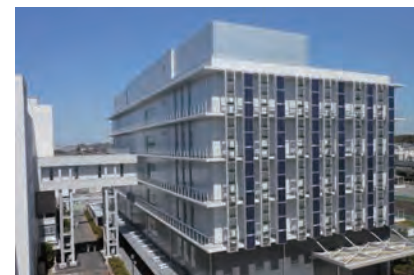
壁面に太陽光発電設備を装備したニコン横浜製作所の建物
