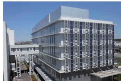
壁面に太陽光発電設備を装備したニコン横浜製作所の建物
